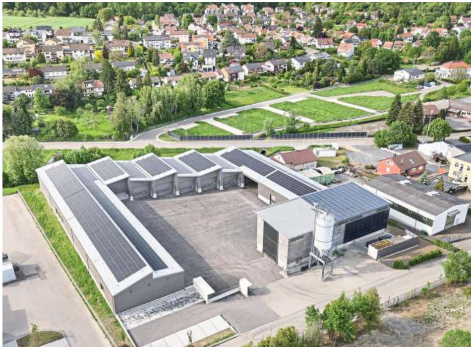
Bei den ausgezeichneten Objekten wurde auch auf Holz-Hybrid-Bauweise und Photovoltaik gesetzt. Wie hier bei der neuen Straßenmeisterei in Maulbronn. Foto: Simon Sommer
