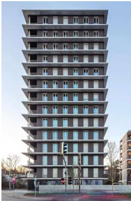
Das Holz-Hybrid-Hochhaus CARL in der Nahaufnahme. Foto: HGEsch
