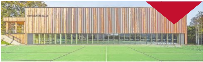
„Unaufgeregt und angemessen“: die Turnhalle auf dem Campus der Heynlintschule.
