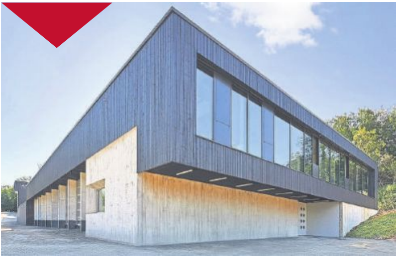
Wenige, präzise Maßnahmen genügten, um Kelterns Feuerwehrhaus „eine Identität und architektonische Qualität zu verleihen“.
