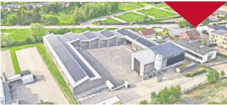
Maulbronns neue Straßenmeisterei verbinde „architektonische Qualität mit einem konsequent nachhaltigen Konzept“.
