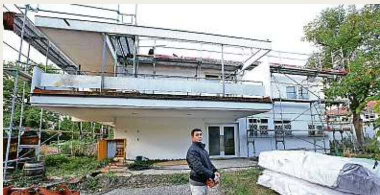
Die Villa Witzemann an der Etival-/Nuitstraße ist eingerüstet.
