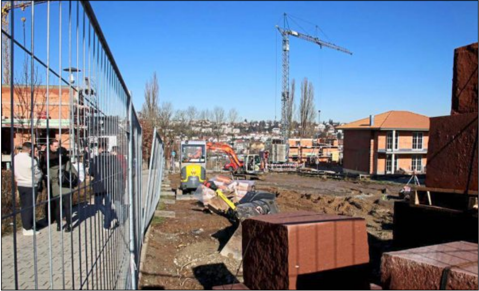
PLATZ FÜR SPASS: Die Gestaltung für den Spielplatz im Baugebiet „Lange Gewinn“ läuft. Hier soll etwa eine Hügellandschaft mit Trampolinen entstehen. Foto: Ehmann
